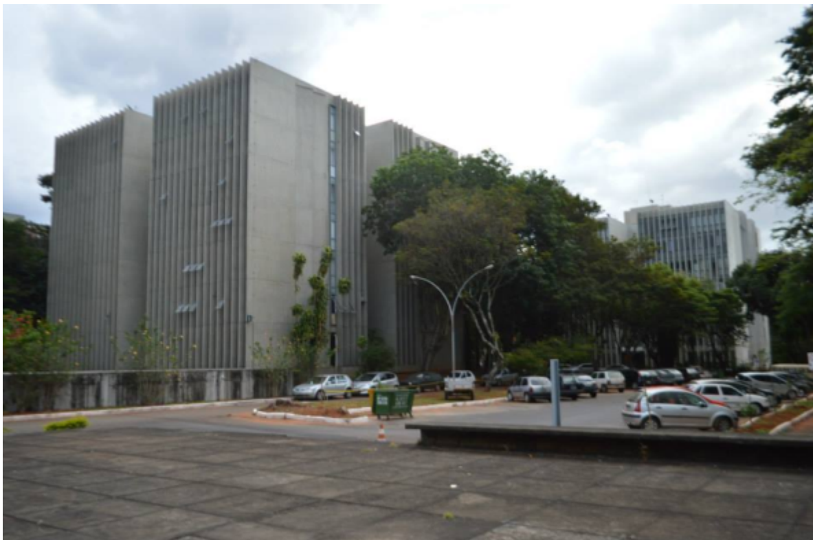
Imagem 5: desnível correspondente à torre. Fonte: Thiago Abreu 7
