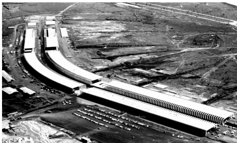
Fig. 4 - Foto aérea do ICC e do campus em construção. Fonte: UnB Agência – www.unb.br .
