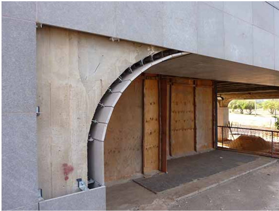
Fig. 20 – Ed. Portobrás. Fixação do basalto tipo “insert” | Fonte: arquivo do autor (2013)
