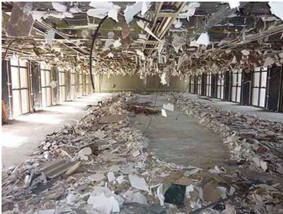
Fig. 19 – Ed. Portobrás. Interior de um pavimento tipo | Fonte: arquivo do autor (2013)
