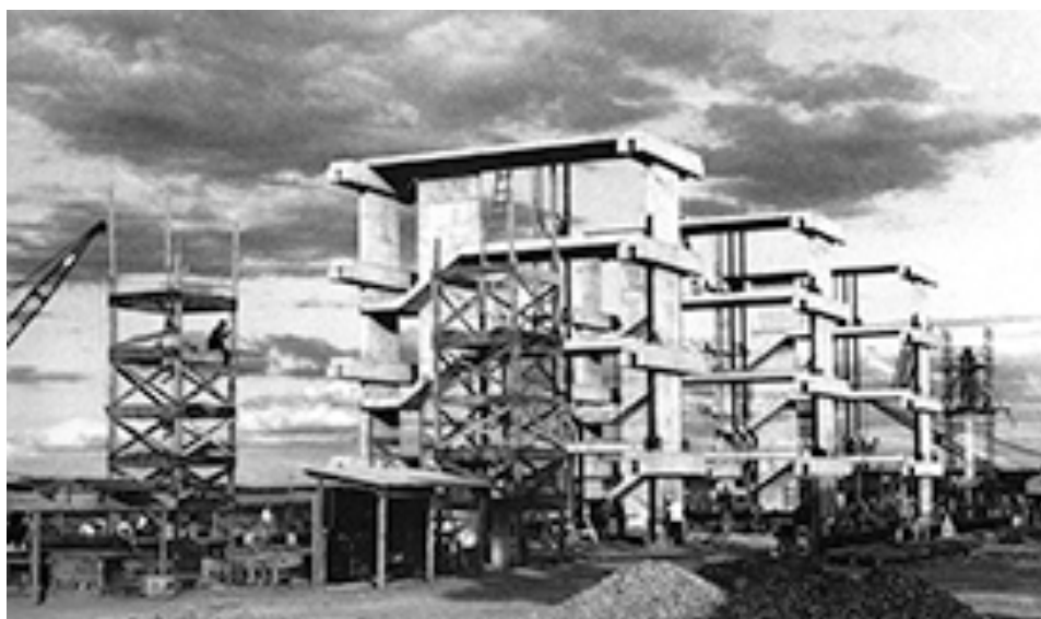
Fig. 4 – Prédios da Colina em construção | Fonte: Giancarlo Latorraca (1999)
