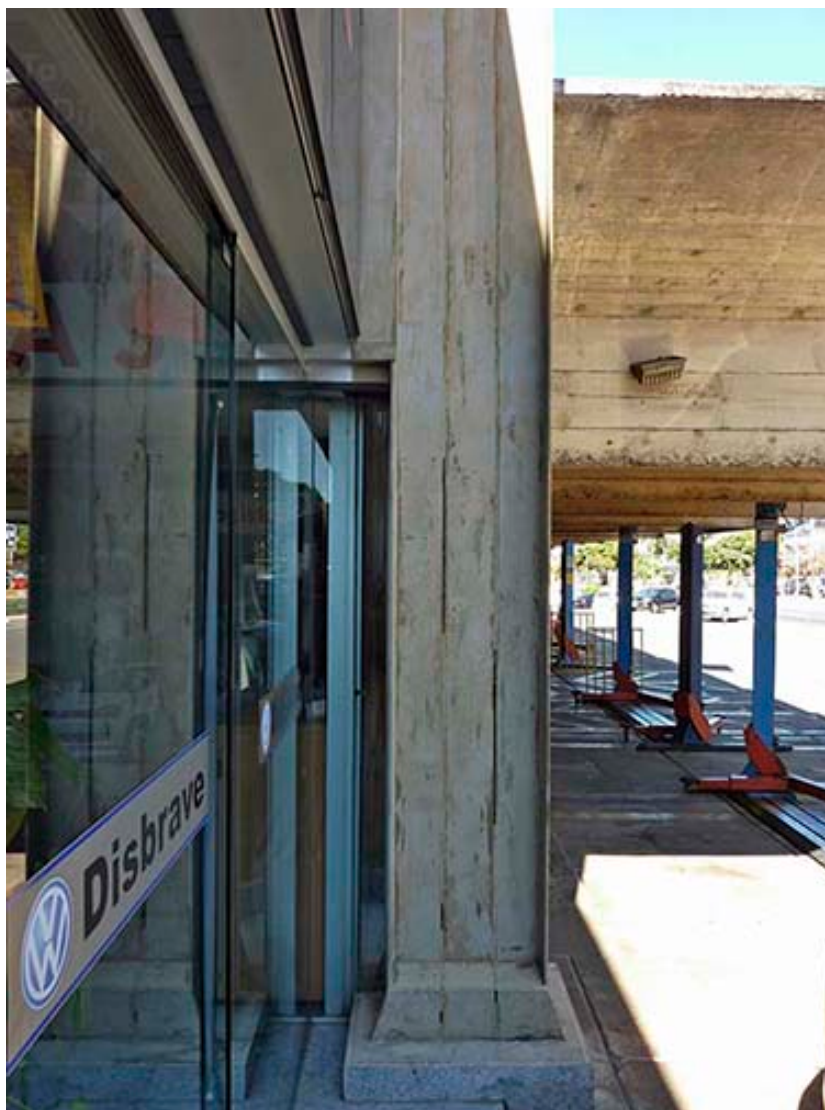
Fig. 16 – Disbrave. Pilar metálico (perfil I) imitando concreto | Fonte: arquivo do autor (2013)
