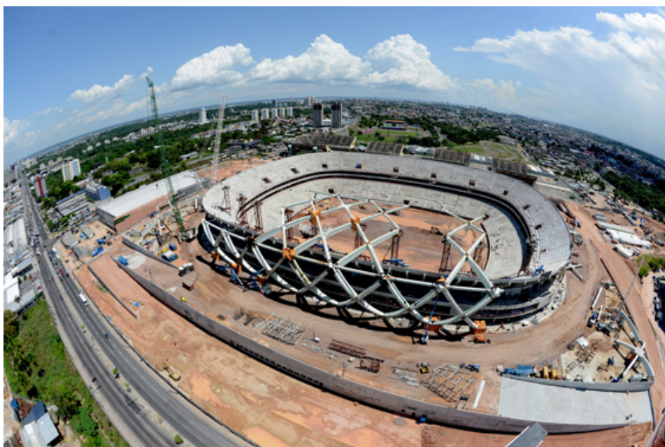
Fig. 07 – vista aérea da Arena da Amazônia
