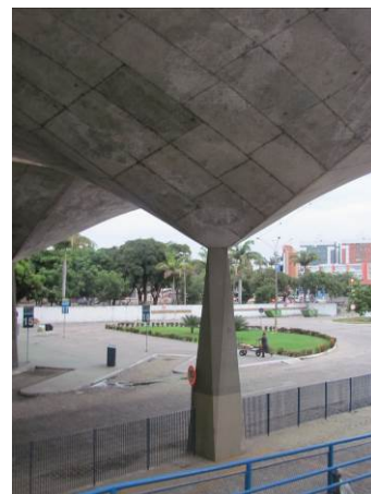
Figura 09 – O módulo “cogumelo” do Terminal Rodoviário Eng. João Thomé, 1973. Arq. Marrocos Aragão Fonte: Acervo Margarida Andrade
