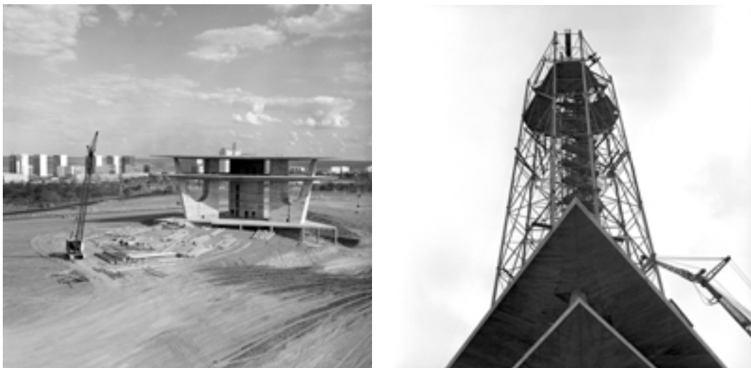
Figura 6 - Montagem da estrutura metálica da Torre. Fonte: Arquivo Público do Distrito Federal.
