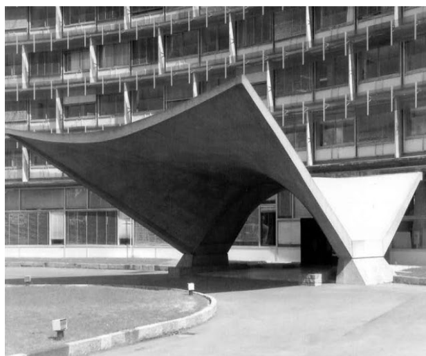
Fig. 22: Marquesina de acceso, edificio de la Secretaría de la Unesco.
