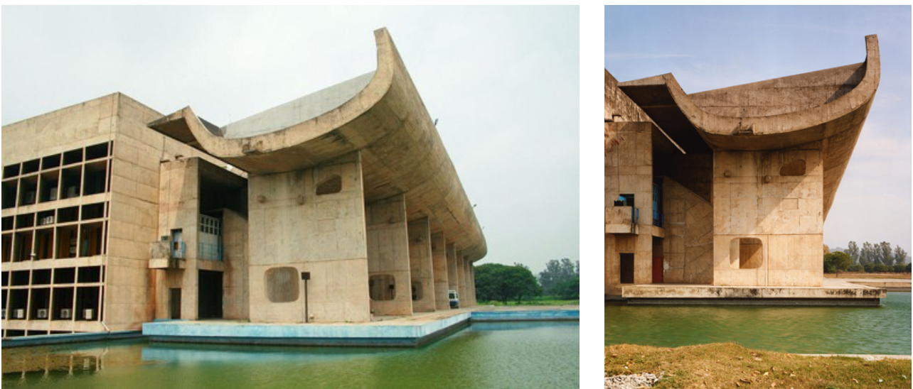
Fig. 24y 25: Paraboloides de la cubierta del Edificio de la Asamblea de Chandigarh. Le Corbusier, 1954 – 1964.
