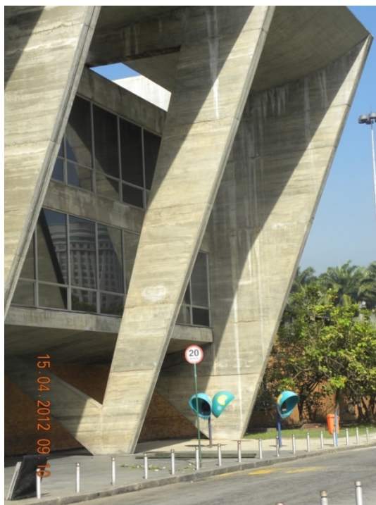
Figura 2 – MAM-Rio – Proteção dos raios solares no Bloco de Exposições, fachada Norte Foto: Alvaro Costa, abr. 2012.
