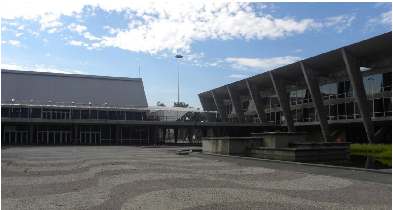
Figura 1 – MAM-Rio – Teatro e Bloco de Exposições Mudanças no projeto original e precário estado de preservação do entorno Foto: Alvaro Costa, abr. 2012.
