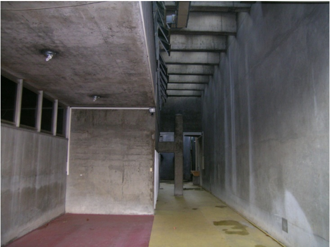
Figura 7 – vista do abrigo de autos e acesso à residência Telmo Porto – foto do autor
