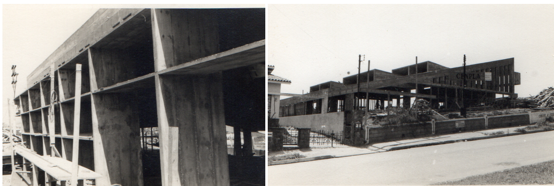
Figuras 17 e 18 – Fotos da residência durante a construção. Fonte: acervo do arquiteto Arnaldo Martino.
