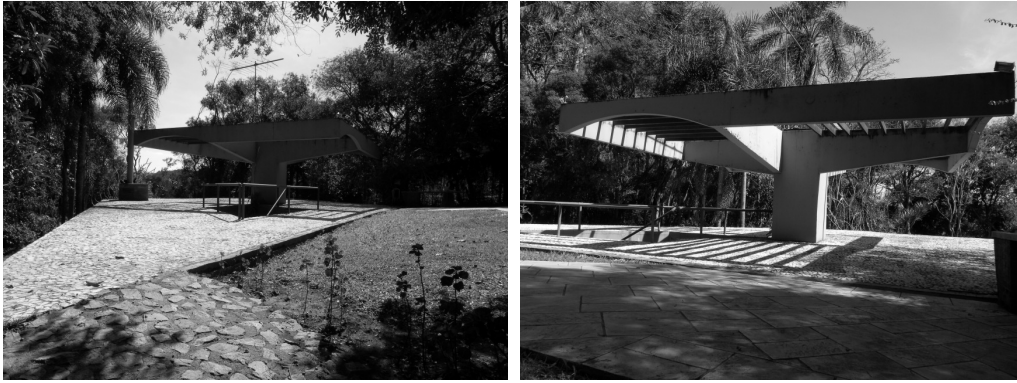
Figuras 30 e 31 – Vista da fachada principal de da caixa d’água da residência Casa da Árvore. Fonte: autora.
