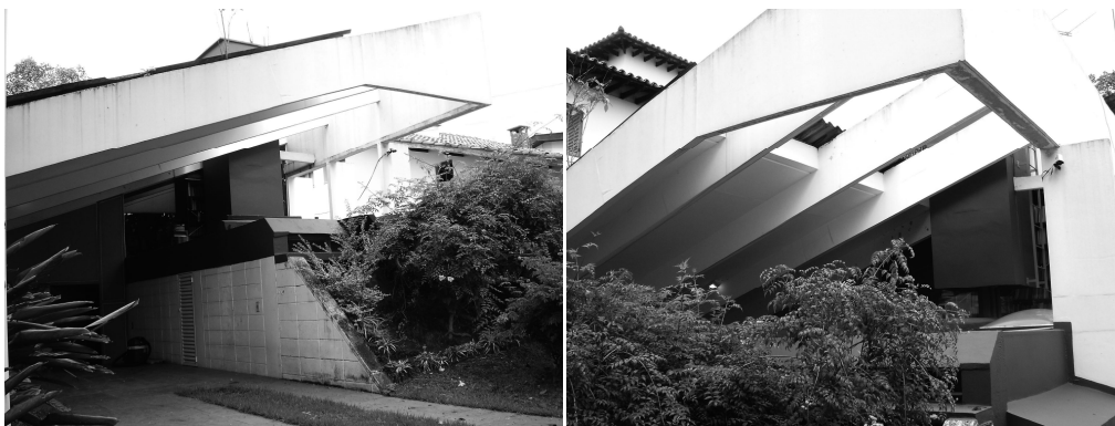
Figuras 23 e 24 - Fotos da cobertura. Fonte: autora.
