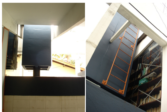
Figuras 25 e 26 – Fotos da caixa d'água. Fonte: autora.
