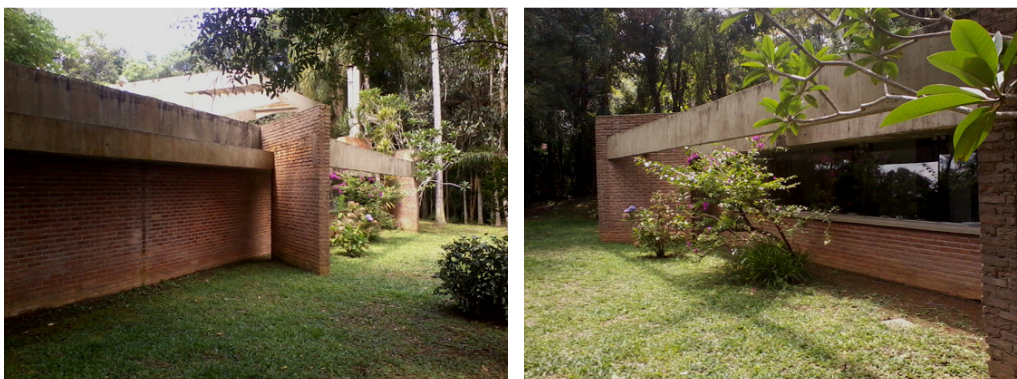
Figuras 35 e 36 – Fachada dos fundos. Fonte: autora.
