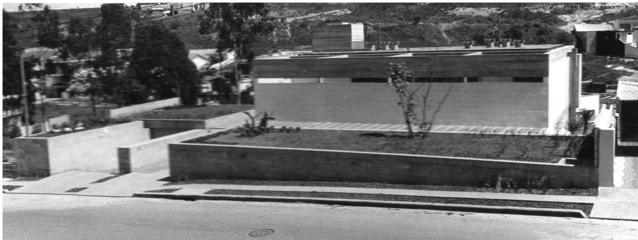
Figura 1 - Fachada principal da residência Tereza Martino. Fonte: acervo do arquiteto Arnaldo Martino.
