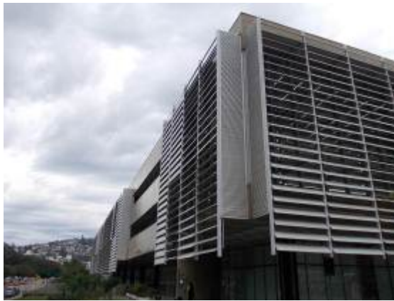
Figura 8 - Edifício ELETROSUL. Detalhe brises metálicos. FOTO: Yunes, 2013
