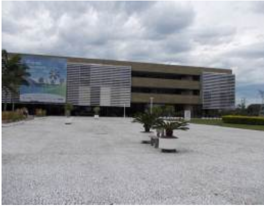
Figura 9 - Edifício ELETROSUL. Interior, esplanada de acesso em petit pavé . FOTO: Yunes, 2013
