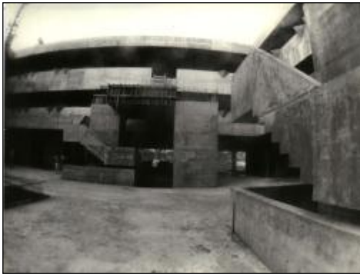
Figura 3 - Edifício em construção. FONTE: ELETROSUL, 1977.
