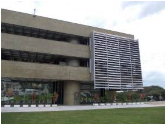
Figura 7 - Edifício ELETROSUL. Detalhe das sacadas em concreto aparente. FOTO: Yunes, 2013
