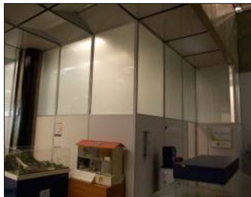
Figura 15 - Edifício ELETROSUL. Interior, detalhe divisórias e forro. FOTO: Yunes, 2013
