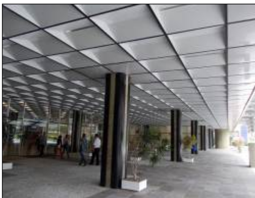
Figura 14 - Edifício ELETROSUL. Detalhe pilares e forro. FOTO: Yunes, 2013
