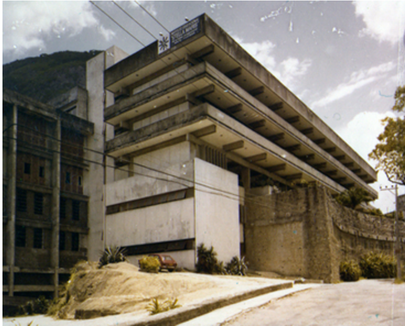
FIGURA 7 Colégio Stella Maris . Rio de Janeiro . Estrada do Vidigal, 75 . 1966-1968 Vista Frontal . Acesso Principal (em construção) Acervo Escritório Edison Musa
