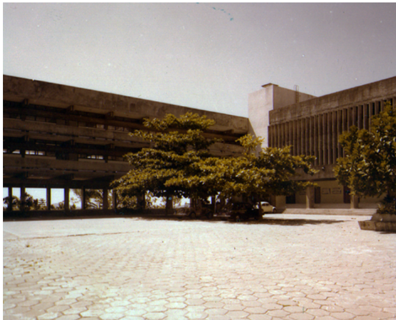
FIGURA 8 Colégio Stella Maris . Rio de Janeiro . Estrada do Vidigal, 75 . 1966-1968 Pátio Interno, ainda sem a malha de piso definitiva; Bloco das Salas de Aulas, à esquerda; Auditório e Capela à direita (com brise vertical); e Bloco Articulador ao fundo (mais alto, ao centro). Acervo Pesquisa Escritório Edison Musa
