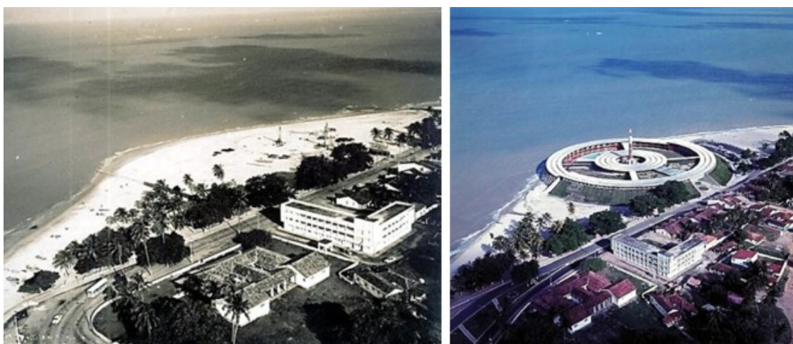
Figura 4: (à esq.) Banco de areia onde foi implantado o Hotel, com vista do bate estacas à época da construção; (à dir.) Hotel Tambaú logo após sua Inauguração (1971).
