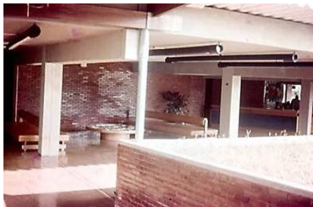
Figura 8: (à esq.) Pannel de cobogós cerâmicos – leveza, transparência, permeabilidade à luz e à ventilação natural; (à dir.) Fechamentos internos em tijolos cerâmicos maciços à vista - ambiente da recepção do hotel, logo após sua inauguração -1970.
