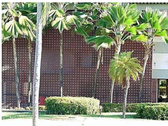
Figura 8: (à esq.) Pannel de cobogós cerâmicos – leveza, transparência, permeabilidade à luz e à ventilação natural; (à dir.) Fechamentos internos em tijolos cerâmicos maciços à vista - ambiente da recepção do hotel, logo após sua inauguração -1970.
