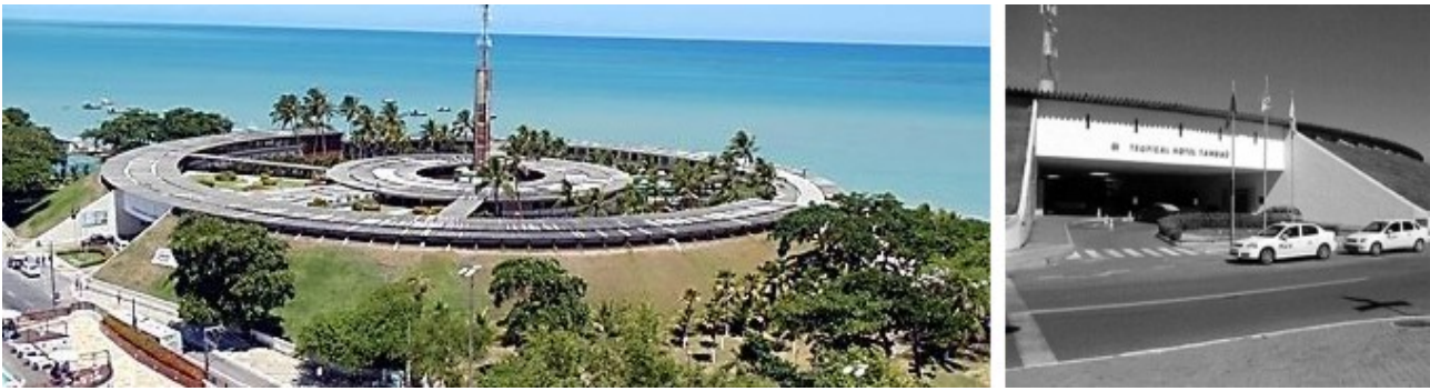
Figura 7: Areia sobre o talude assume função simbólica de dunas areia (à esq.); vista do acesso principal através de túnel em rampa enclausurada, que remete ao telúrico e ao pesado (à dir.). Fonte: Fotos de Germana Rocha (2010).
