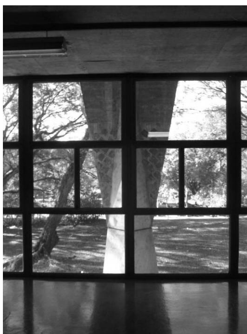
21 Caixilho e pilar externo. Foto Felipe Contier, 2011.
