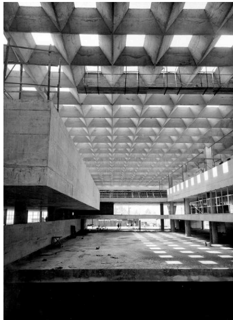
11 Andaime suspenso para tratamento da junta de concretagem da grelha de cobertura. Notar a concretagem de parede do estúdio ao fundo e a instalação do caixilho na biblioteca (esq.). Acervo BFAUUSP.
