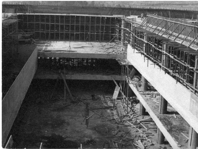
5 Edifício da FAUUSP em construção. Acervo BFAUUSP.
