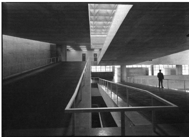
23 Rampas e guarda-corpo de alumínio. Foto José Moscardi (?). Acervo BFAUUSP
