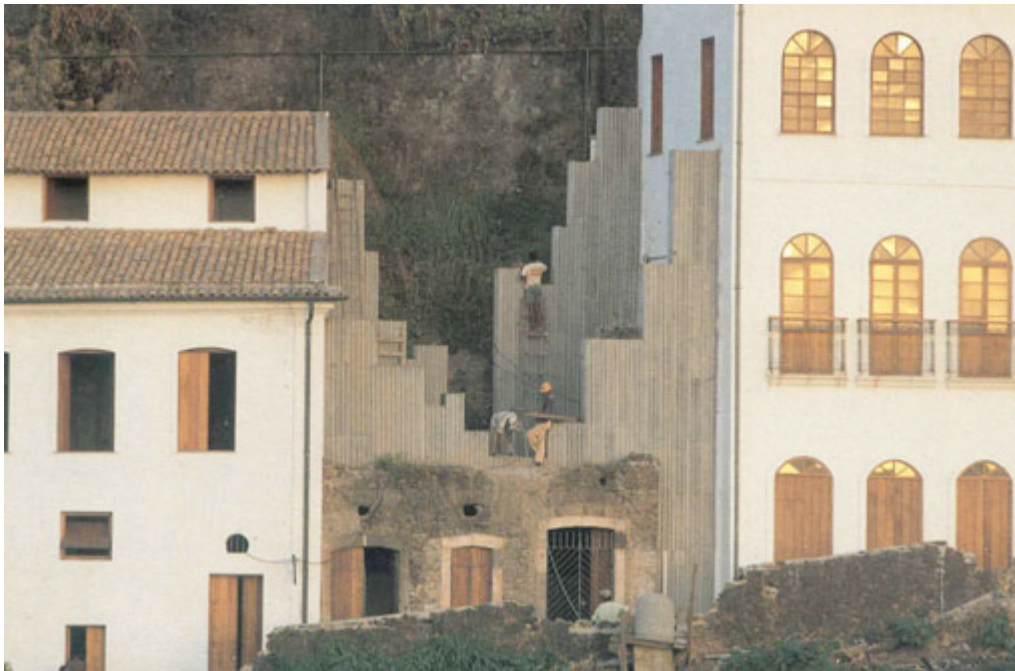
Imagem 03. Ladeira da Misericórdia. Projeto Lina Bo Bardi, Marcelo Ferraz e Marcelo Suzuki, com a participação de Lelé, 1987-9. Detalhe dos contrafortes em argamassa armada e a estrutura branca dos casarões do século XVIII. Foto: Mara Sánchez Llorens. Fonte: http://img.interempresas.net/fotos/416489.jpeg .
