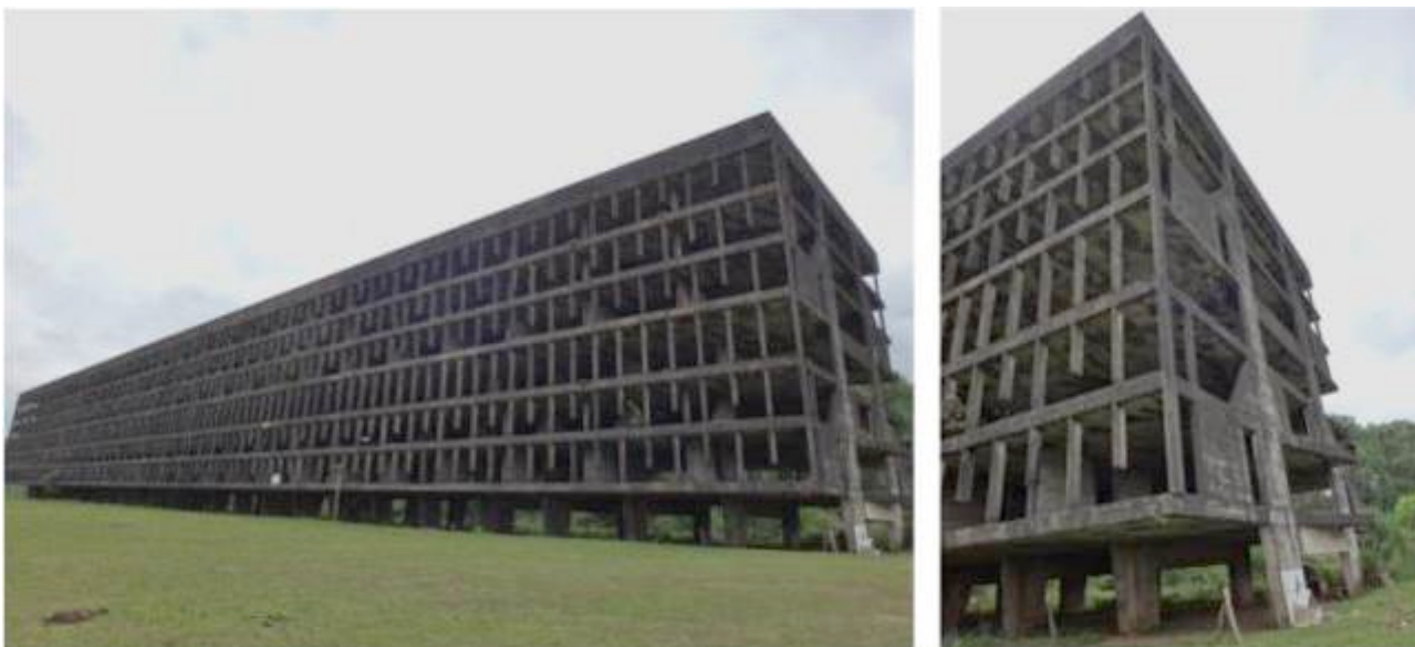
Fig. 3: Edifício para residência masculina, estado atual da estrutura da unidade de habitação.
