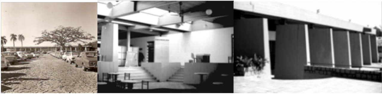
Fig. 7 - Clube do Professor Gaúcho - CPG, Moacyr Moojen, João J. Vallandro, 1966, Porto Alegre - RS. À esquerda: recuo de jardim e estacionamento. No meio: Iluminação zenital, viga calha, vigas de madeira laminada, desnível e salão de festas. À direita: fachada fundos, leste. Fonte: Acervo FAM.
