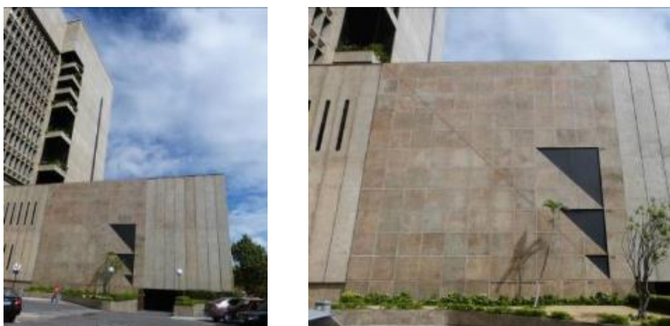
Figura 16 - Coordenação Modular na fachada Fonte: Amanda Casé (2012)
