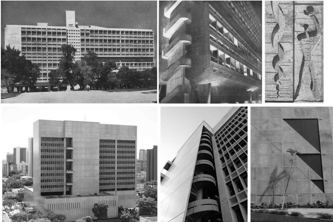
Figura 31 - Unité d' Habitation de Marseille (1952) e Ministério da Fazenda de Fortaleza (1975)
