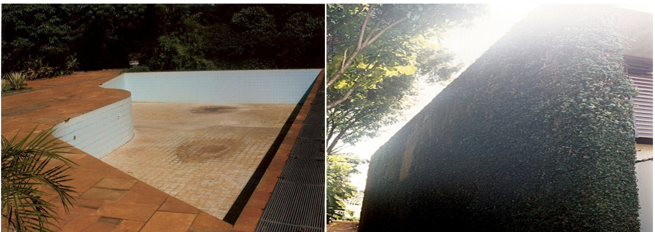
Figura 12, 13 – Casa em Catanduva, 1984 (2º. Projeto de Mendes da Rocha), piscina; lateral. Fonte: (Soares 2007), cedida autor.
