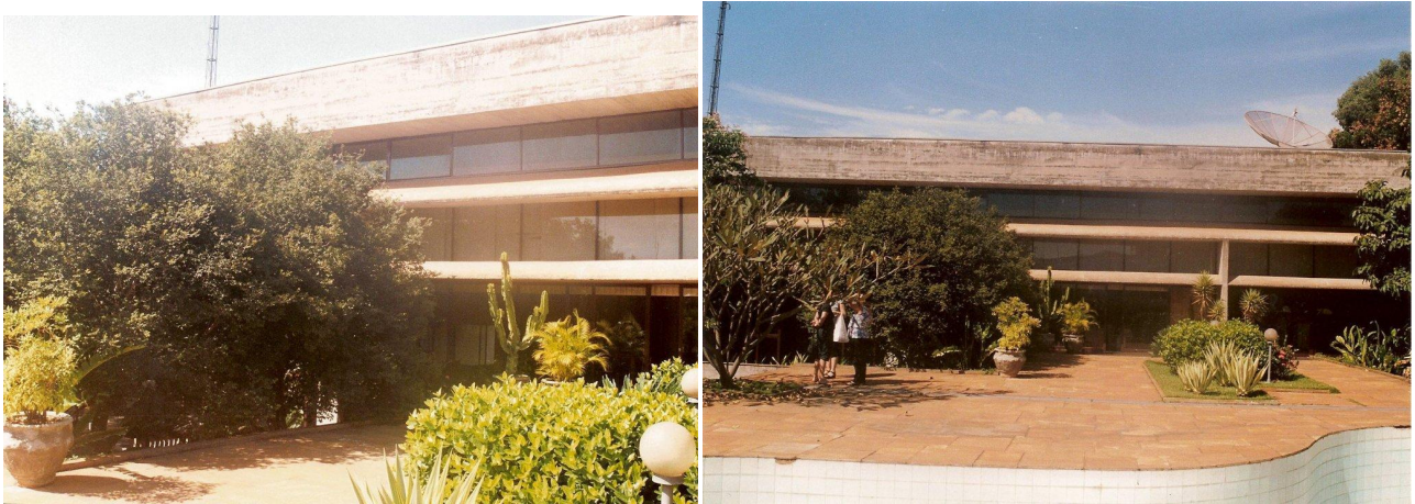
Figura 10, 11 – Casa em Catanduva, 1984 (2º. Projeto de Mendes da Rocha), vista fundos. Fonte: (Soares 2007), cedida autor.
