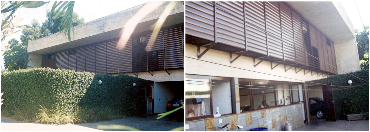
Figura 08, 09 – Casa em Catanduva, 1984 (2º. Projeto de Mendes da Rocha), vista frontal. Fonte: (Soares 2007), cedida autor.
