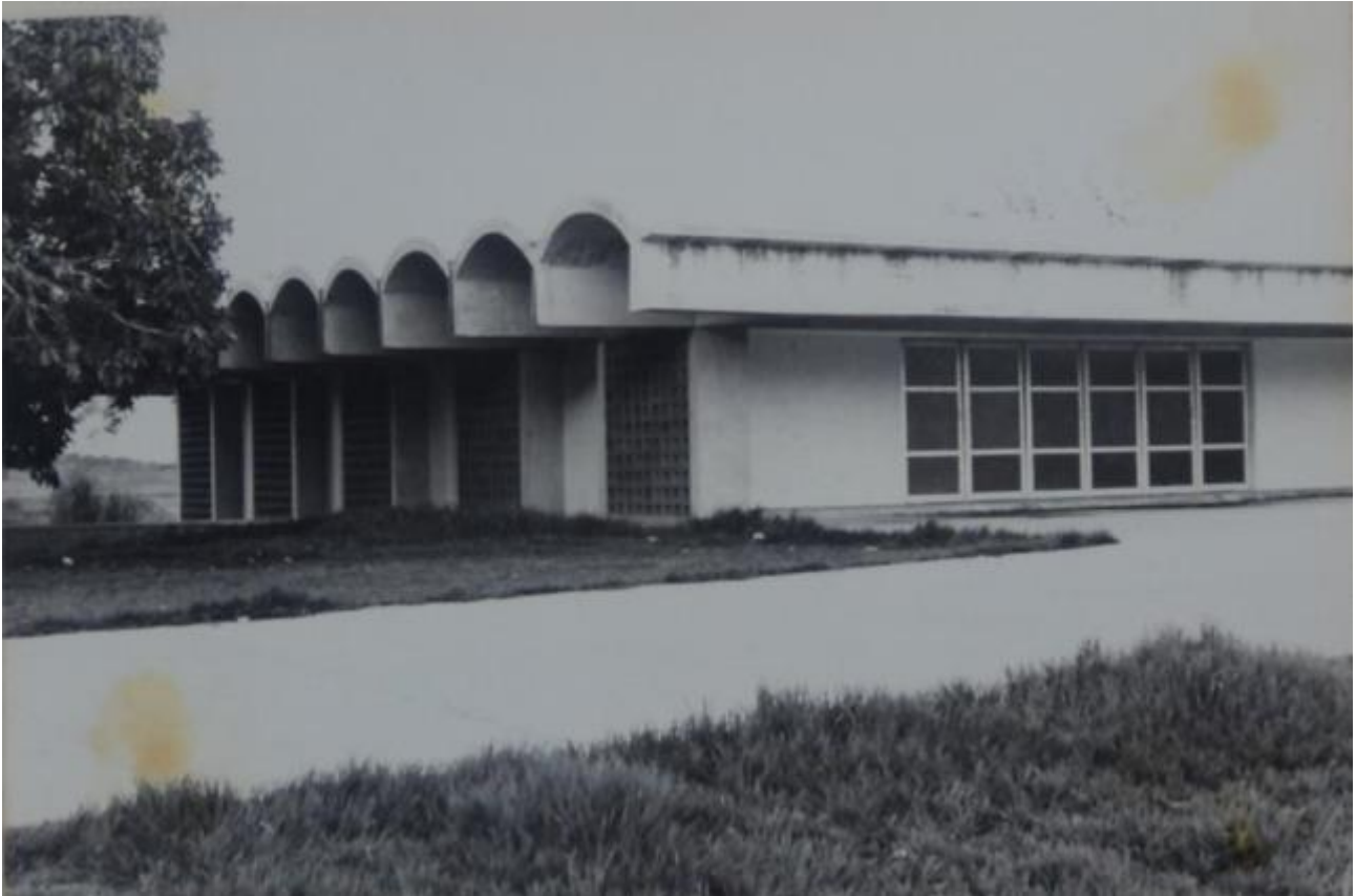
Visada externa do Auditório do Instituto de Biologia 1973. Fonte: Arquivo da Prefeitura do Campus da UFBA.
