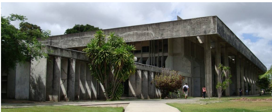
Figura 10: Vista do edifício da Biblioteca Central da UFPB, em João Pessoa, projeto dos arquitetos José Galbinski e Armando de Carvalho. Fonte: Arquivo da autora (2010)
