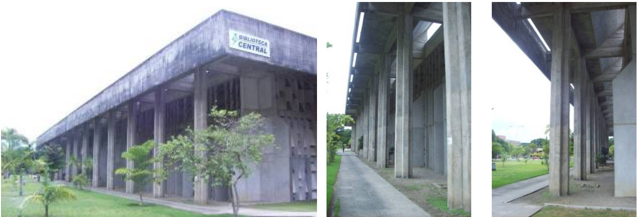
Figuras 13: Imagem geral com destaque para a colunata e o detalhe da junção entre os pilares e as vigas.
