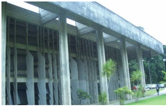
Figuras 17: Destaque para o amplo pano de brises-soleil nas fachadas e dos detalhes construtivos
