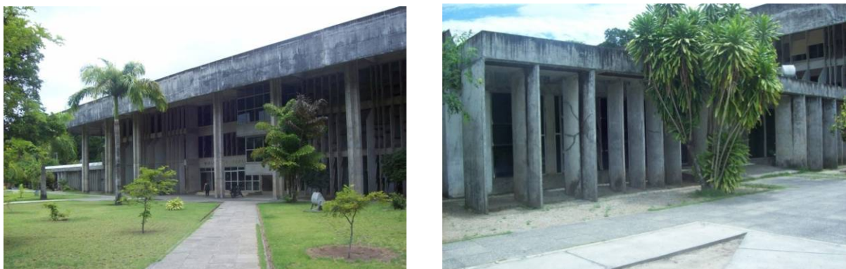
Figuras 14: Acesso principal ao edifício composto por três pavimentos, e o edifício administrativo e de serviços composto apenas por um pavimento térreo (ao fundo o edifício principal).
