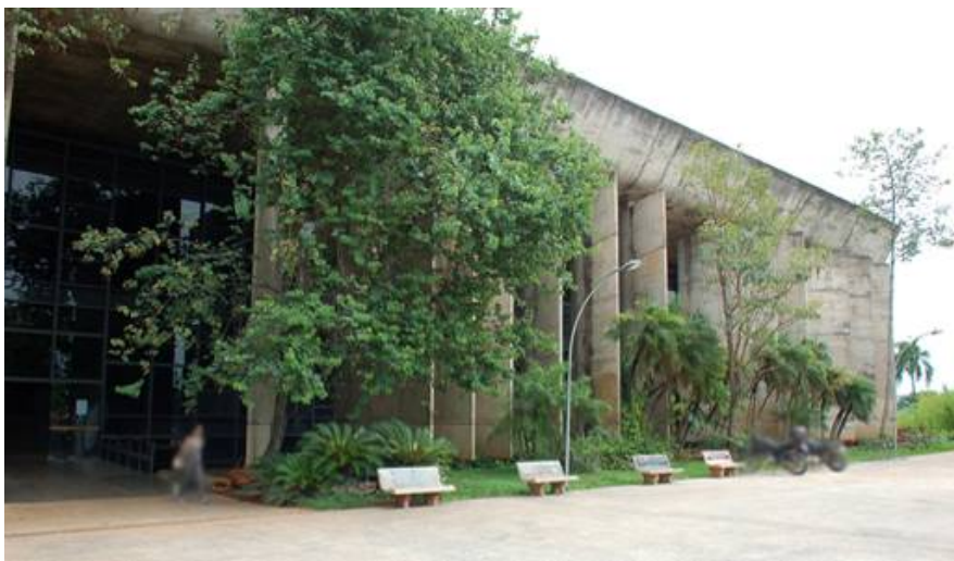
Figura 1: Fachada da Biblioteca Central da UnB, em Brasília, projeto dos arquitetos José Galbinski e equipe. Fonte: Arquivo da autora (2011)
