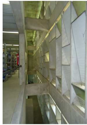
Figuras 17: Destaque para o amplo pano de brises-soleil nas fachadas e dos detalhes construtivos
