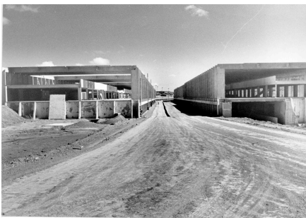
Figura 8 – Construção do Instituto Central de Ciências
