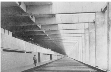
Figura 9 – Pérgolas que delimitam a área central do edifício
