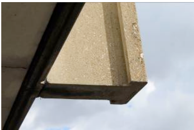
Figura 3: Detalhe do perfil de concreto na fachada externa. Fonte: Elaborada pelo autor (ago. 2012).
