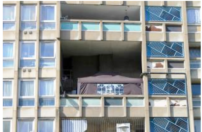
Figura 14: Vista da fachada interna ao jardim do bloco menor. Fonte: Elaborada pelo autor (ago. 2012).
