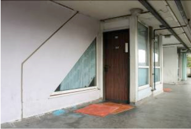
Figura 5: Vista do acesso a uma das unidades, no terceiro pavimento do bloco maior. Fonte: Elaborada pelo autor (ago. 2012).
