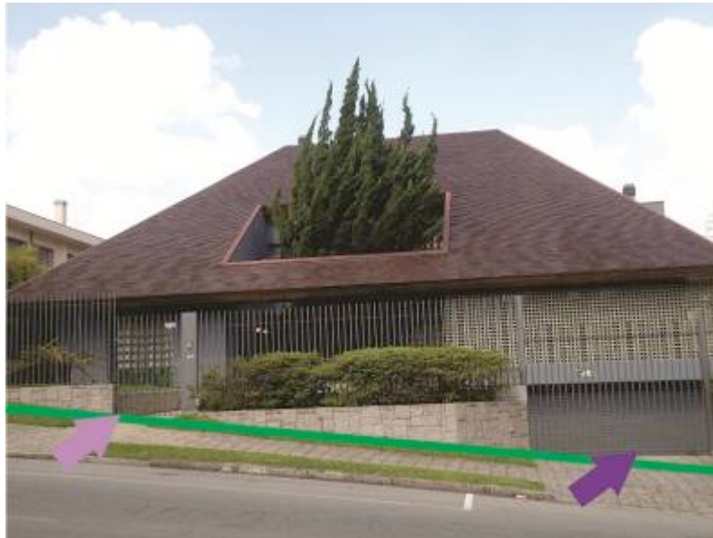
Figura 52. Desnível com hierarquia de acessos. Fonte: Autora.
