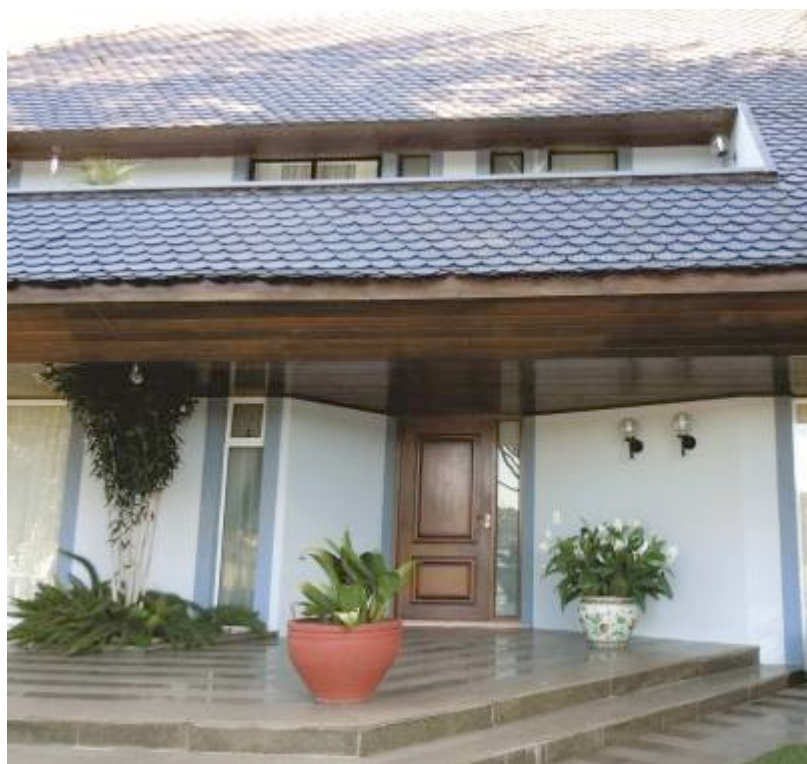
Figura17. Inclinação do telhado e telha escama de peixe. Fonte: Autora
