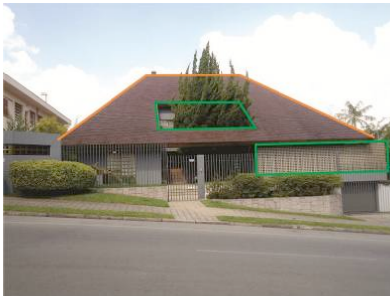
Figura 57. Inclinação do telhado, zenital com vegetação e fechamento em cobogó. Fonte: Autora.
