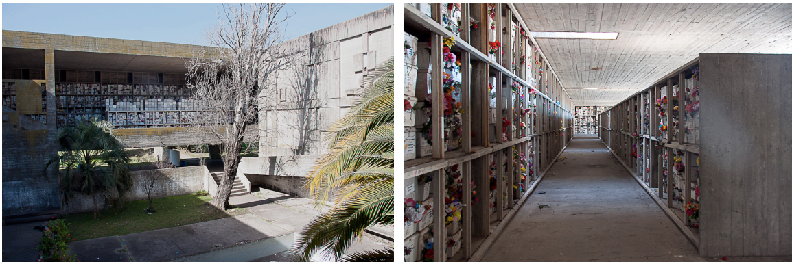
Claustro y galería oeste
