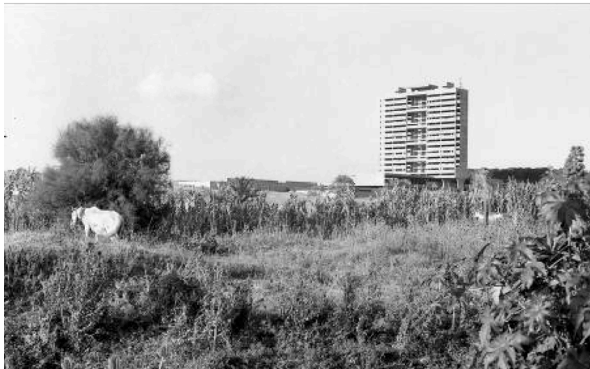
Fotografía de la obra desde el ángulo sudoeste, ca. 1967. Autor: Justino Serralta. Negativo CDI, IHA.
