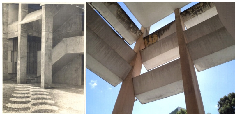
Figura 11 (esq.): Estrutura aparente, painel ao fundo e desenho da calçada. Acervo pessoal de Geraldo Santana. Figura 12 (dir.): Brises do Bloco Gonçalves Maia. Foto Mariama Morais 27/05/2013.
