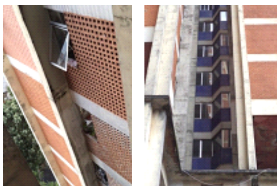
Figuras 1 e 2: Tijolo aparente e cobogós (esq.) e pastilhas azuis no corpo de circulação vertical (dir.). Foto da autora 27/05/2013.
