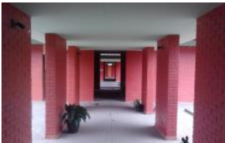
5) Brás Pires, vista da circulação externa.
