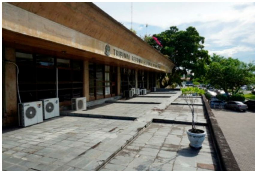
Fig. 21 – Imagem do terraço do 1º Pavimento que serve de marquise de proteção do pavimento térreo. No corte do Anteprojeto original, essa área possuía pavimento em grama protegido com guarda-corpo. Fotos: Autores.
