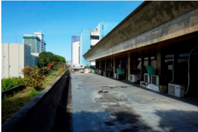
Fig. 22 – Imagem do terraço do 2º Pavimento. Fotos: Autores.
