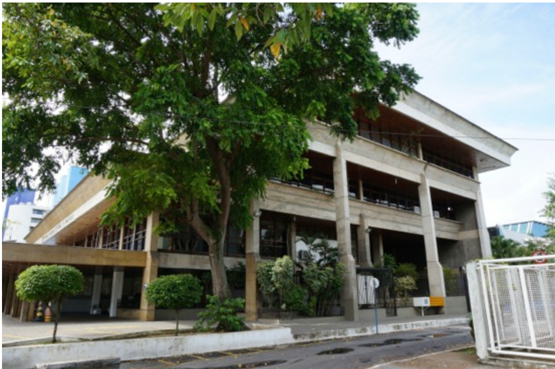
Fig. 2 – Fachada lateral da Sede do TRE – AM. Fotos: Autores.
