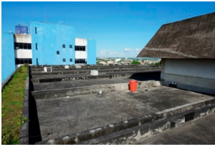
Fig. 23 – Imagem da laje de cobertura do TRE-AM, casa de máquinas. Fotos: Autores.
