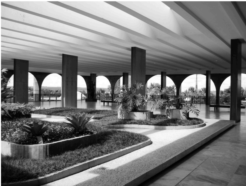
Figura 2: A abertura zenital na laje, entre o vigeamento unidirecional, dá passagem à luz sobre o jardim de Burle Marx. Nota-se parte do conjunto de pilares (revestidos em madeira) que ajudam na sustentação da cobertura e da caixa portante. Ao fundo, as parábolas dos arcos do peristilo em concreto aparente tocam suavemente o perímetro da cobertura quadrangular.
