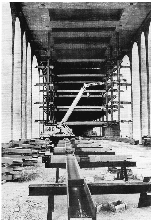
Figura 6: Nesta imagem de 1972, as arcadas portantes já estão erguidas e os pavimentos suspensos do volume interno ainda encontram-se em fase de construção e de montagem do cimbramento. Na parte inferior da laje de cobertura, o caminhamento das vigas transversais coincide com o encontro dos arcos dos pilares e com a saída dos elementos estruturais em aço (reforçando e mantendo estaticamente rígido e integrado todo o edifício).
