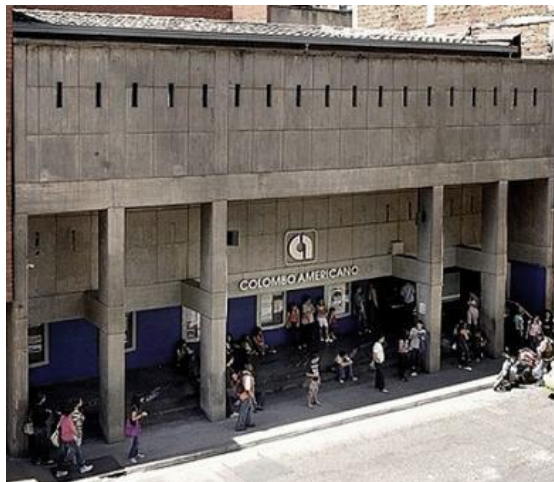
2. Centro Colombo Americano, edificio construido en el año 1968. Fuente: Archivo Centro Colombo Americano.
