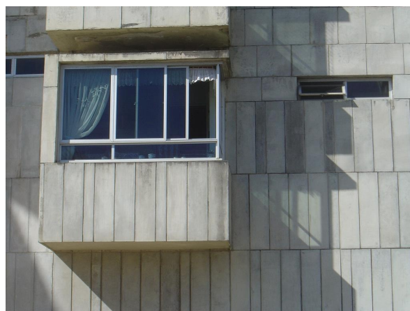
Esq.: Fig.50: Edifício Parnamirim, Geraldo Santana. O detalhe da peça de concreto que saca do volume principal, gerando a moldura da janela, demonstra o cuidado com o encaixe das peças. Foto: A. Cantalice.
