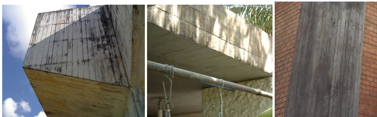
Esq.: Fig.2: Caixa de água da UFPE. Foto: A. Cantalice. Centro.: Fig.3: Residência do arquiteto Luis Lacerda, 1970. Foto: A. Cantalice. Dir.: Fig.4: Edifício Parnamirim, Geraldo Santana. Foto: A. Cantalice.
