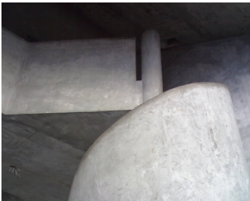
Esq.: Fig.11: Centro de Convenções, Zamoner, Oba e Ramalho, 1978. Vista, demonstrando o jogo de volumes em concreto aparente confeccionado com forma de natureza lisa. Foto: A. Cantalice.
