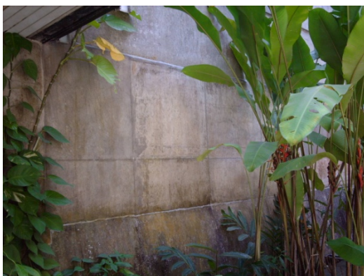
Dir.: Fig.12: Centro de Convenções. Detalhe da textura do concreto com a ação do desgaste do tempo. Foto: A. Cantalice.
