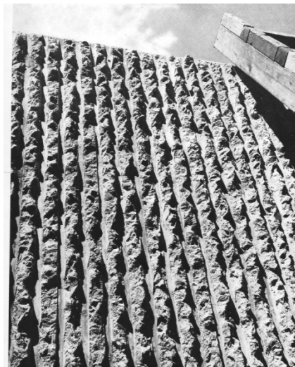
Fig.18-19: Escola de Arquitetura de Yale, Paul Rudolph, 1961-63. Detalhe da textura do concreto e desenho técnico da fôrma e do dente quebrado com marreta, após um breve período de cura. Fonte: BÄCHER, HEINLE, 1967, p.93.
