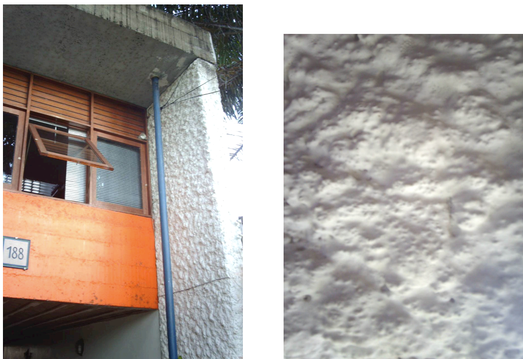
Fig.38-39: Residência do arquiteto Luiz Lacerda, 1970. Esq.: Vista da fachada e do acabamento variado, gerado por meio das técnicas de texturas variadas nos planos. Dir.: Detalhe da áspera textura dos pilares que recebem de revestimento um chapisco grosso pintado de branco. Fotos: A. Cantalice.
