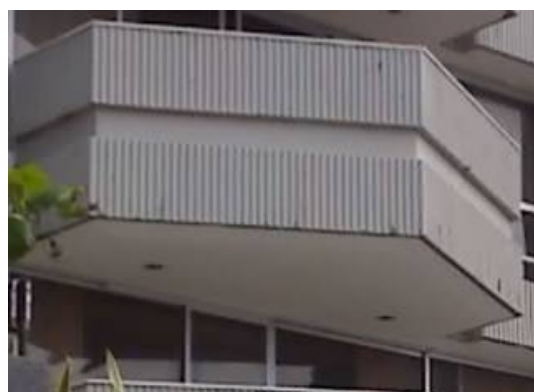
Esq.: Fig.23: BANDEPE, Borsoi, Miranda e Costa, 1969. Detalhe da guarita com as paredes confeccionadas com acabamento ondulado. Foto: A. Cantalice.
