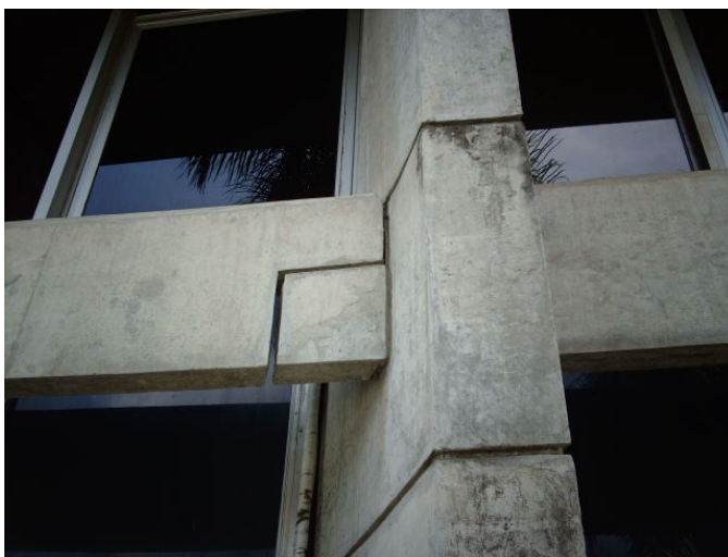
Fig. 16-17: CELPE, Reginaldo Esteves & Vital P. de Melo, 1972. Vista, demonstrando os frisos de encaixe das peças de concreto e a textura das vigas que suportam os brises. Foto: A. Cantalice.
