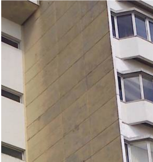
Esq.: Fig.9: Edifício Oásis, Glauco Campello, 1970. Detalhe da textura do concreto da fachada lateral demarcada com frisos horizontais. A fôrma foi claramente reutilizada na construção dessas placas, uma vez que as próprias placas demonstram uma textura característica que demonstra o reuso das mesmas. Foto: A. Cantalice.
