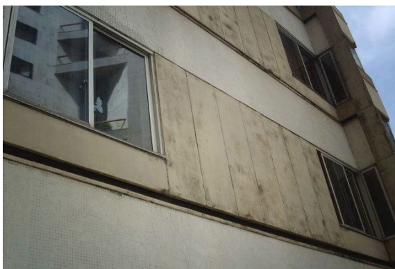
Esq.: Fig.48: Edifício Sahara, Vital P. de Melo, 1973. Fachada lateral, demonstrando a marcação dos componentes da fachada. Foto: A. Cantalice.
