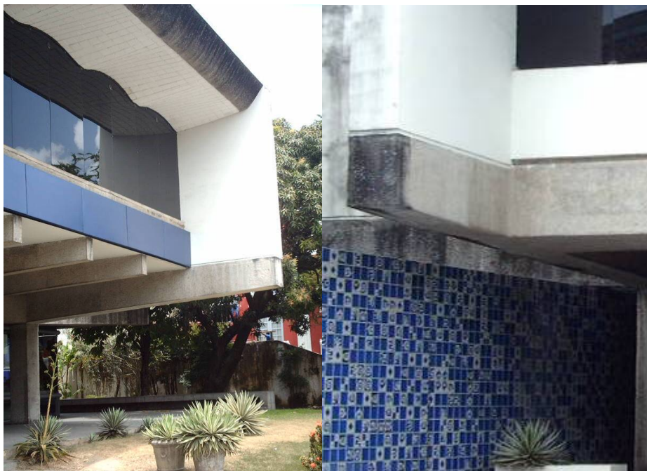
Fig.40-41: Caixa Econômica da Praça da República, Jerônimo & Pontual. Esq.: Vista do contraste entre os diversos materiais empregados. Dir.: Solução bastante comum da época. O friso que conecta o sistema estrutural à vedação vertical. O painel do septo inferior revestido de azulejo azul e branco é outro material de revestimento bastante utilizado na arquitetura local. Fotos: A. Cantalice.
