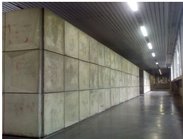
Esq.: Fig.28: NPD-UFPE, Helvio Polito, 1976. Detalhe da peculiar textura das placas de concreto externa. Foto: A. Cantalice.
