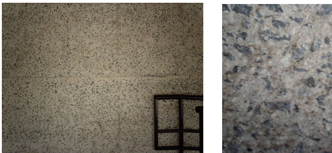
Fig.26-27: Sede da Rede Ferroviária, Svensson & Domingues, 1970. Detalhe do acabamento texturizado das paredes em blocos com essa textura rugosa de brita, marcando o acesso principal. Fotos: A. Cantalice.
