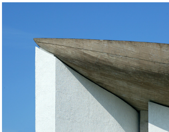
Esq.: Fig.32: Residência Antônio Delboux, São Paulo, Carlos Millan, 1962. Detalhe dos diversos materiais empregados, o concreto aparente, o cobogó e a parede em um grosso chapiscado pintado de branco demonstram uma característica mais fluida em relação à configuração dos materiais. Fonte: Revista AU.
