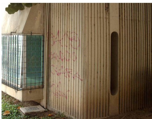
Esq.: Fig.23: BANDEPE, Borsoi, Miranda e Costa, 1969. Detalhe da guarita com as paredes confeccionadas com acabamento ondulado. Foto: A. Cantalice.
