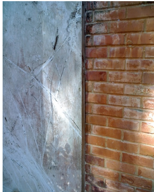
Esq.: Fig.34: Edifício Veredas, Ana Lúcia Barros & Suely Jucá. Detalhe dos frisos que perseguem a área de contato tijolo/concreto. Foto: Fernando Diniz.
