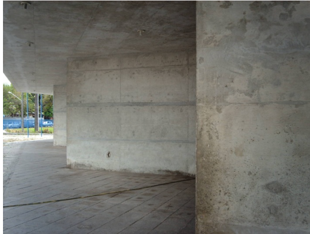
Fig.15: Sede da Rede Ferroviária, Svensson & Domingues, 1970. Detalhe dos septos em concreto maciço confeccionados com fôrmas retangulares. Foto: A. Cantalice.
