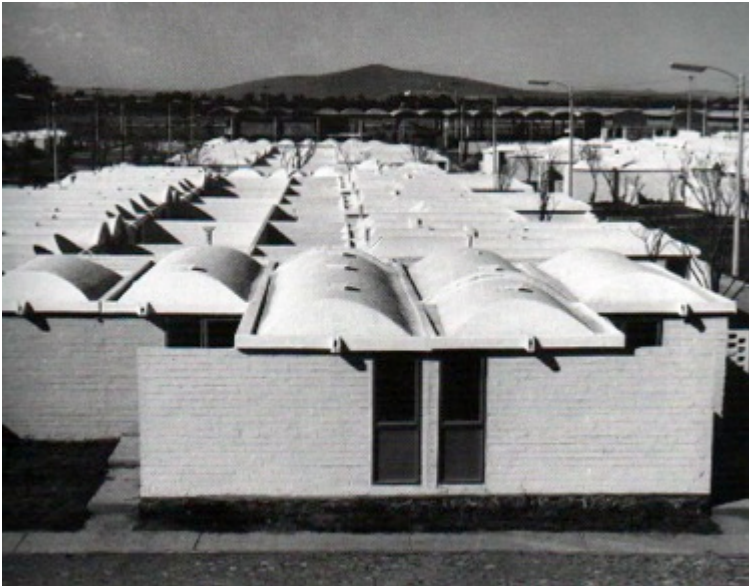
Figura 5. Unidade Habitacional José Clemente Orozco, Guadalajara, Jalisco. México, 1956-1958. Arquitecto: Teodoro González de León. Fonte: Arquivo de Teodoro González de León
