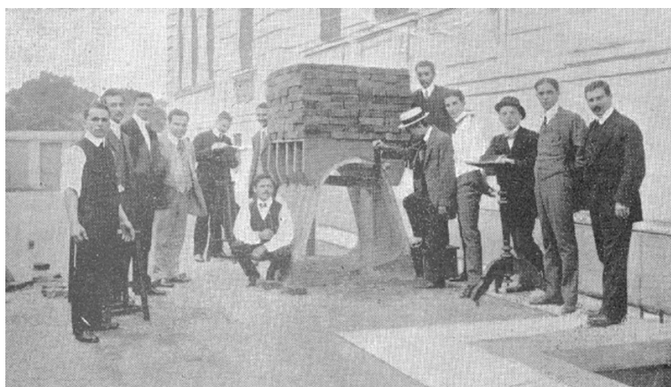
Figura 2 e 3: Ensaio realizado no Gabinete de Resistência de Materiais da Escola Politécnica de São Paulo para testar as galerias desenhadas para a cidade de Jaú, no ano de 1904 (Revista Polytechnica).
