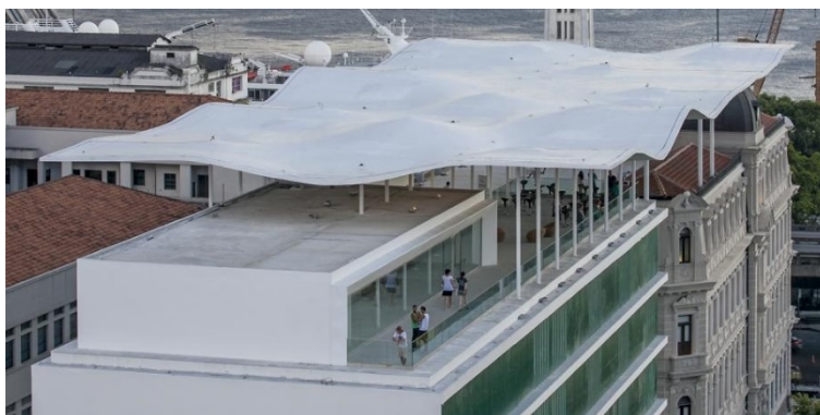
Figura 11. Laje ondulada sobre os blocos. Foto: Metro ao Cubo.
