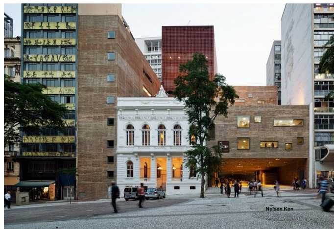
Figura 4. Elevação no calçadão da Avenida São João. Antigo edifício do Conservatório e intervenção contemporânea. Foto: Nelson Kon
