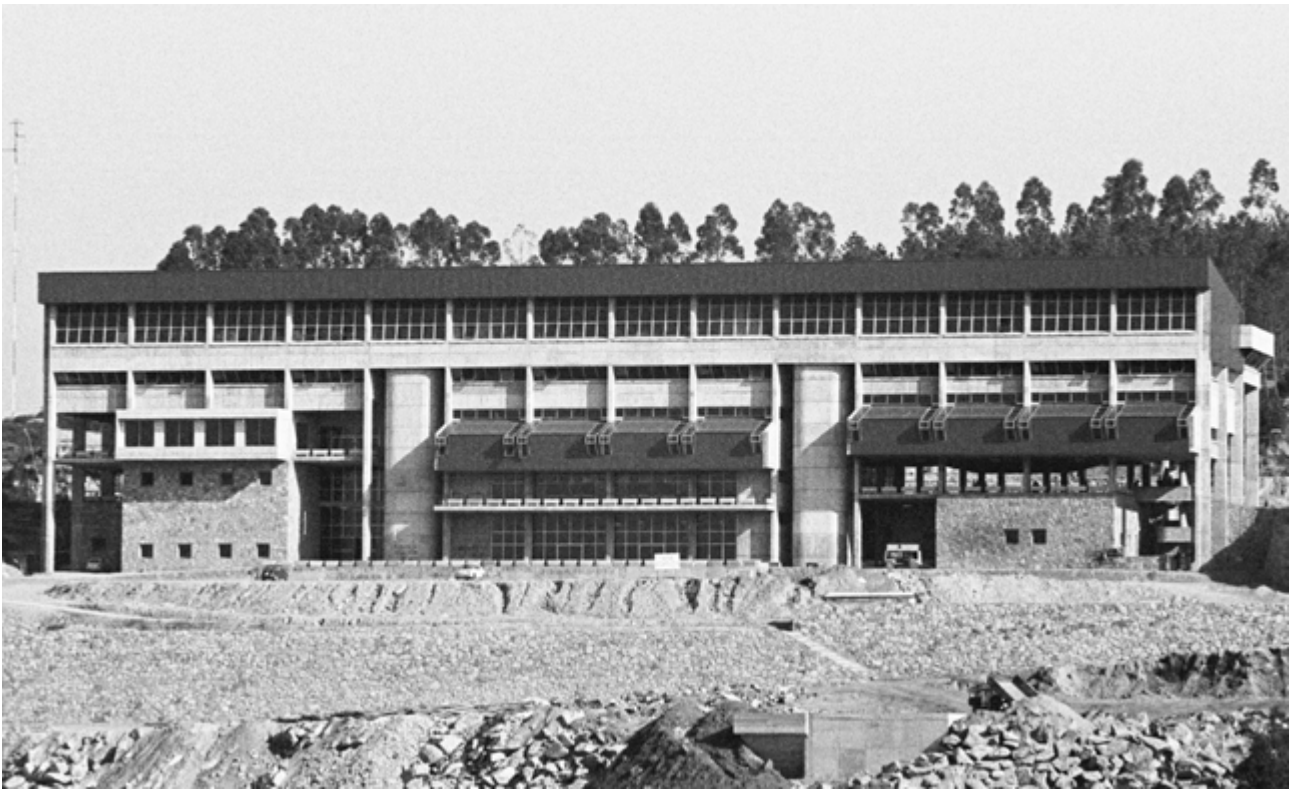
Img. 6: Escuela de Aparejadores en La Coruña
