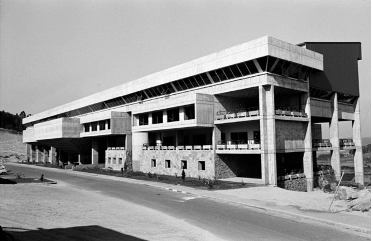
Img. 5: Escuela de Aparejadores en La Coruña
