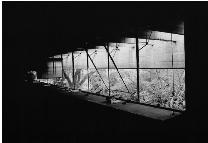
Fig. 19 – Esquadrias residência do arquiteto, Paulo Mendes da Rocha
