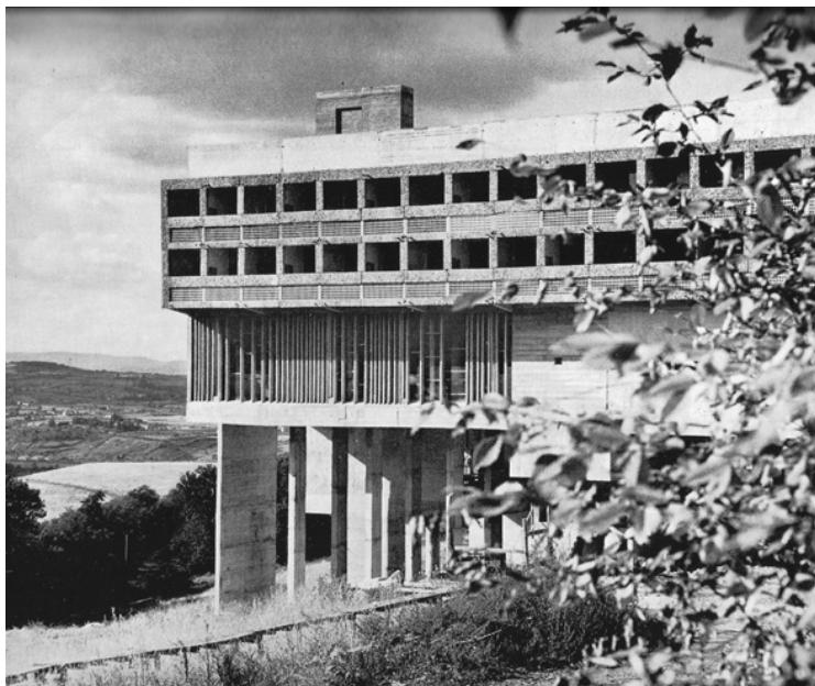
Fig. 24 – Convento Sainte Marie de La Tourette, Eveux-sur-Arbresle, Le Corbusier
